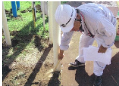
遊具定期点検
